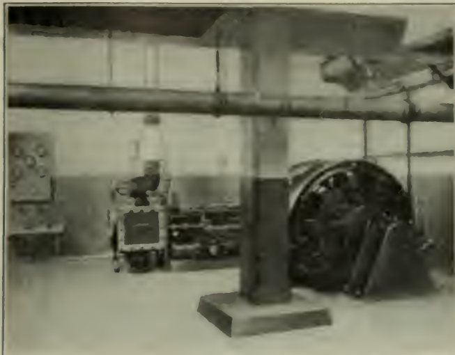
FIG. 10. THE 200-KILOWATT UNIT
